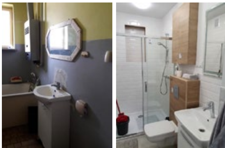
Zdjęcie 24 i 25. Łazienka przed i po remoncie/ modernizacji w Stargardzie. Zmieniono wannę na prysznic.
